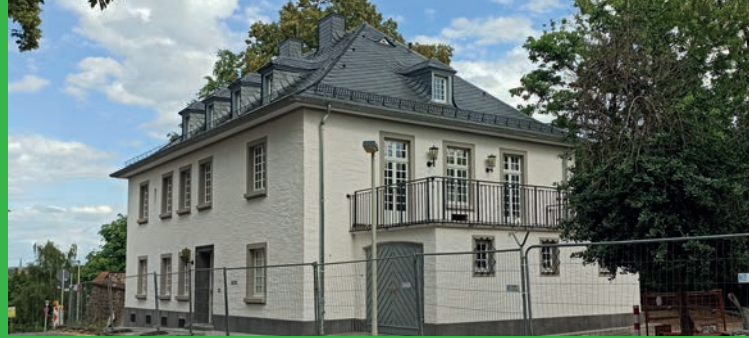
Geburtsaus von Peter Joseph Lenné im aktuellen Sanierungszustand
